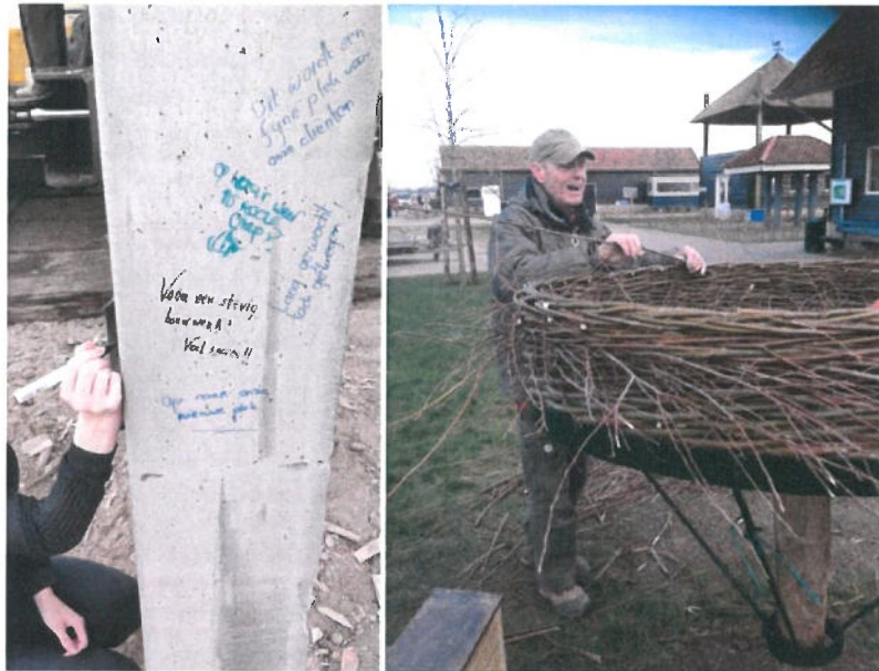
Foto: De eerste paal voor de nieuwbouw voor het dagverblijf en het vlechten de van het ooievaarsnest
