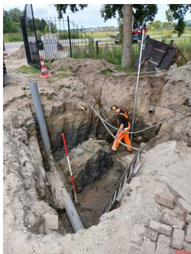
Vorbereiding plaatsen nieuwe pompput.
